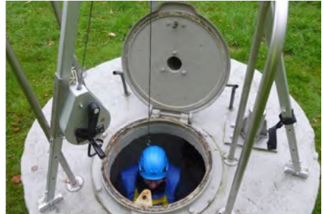
Abb. 23 Höhensicherungsgerät mit Rettungshubfunktion
