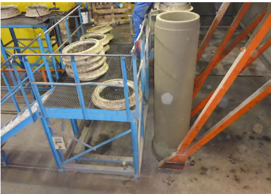
Abb. 47 Arbeitsbühne zur manuellen Nachbearbeitung
