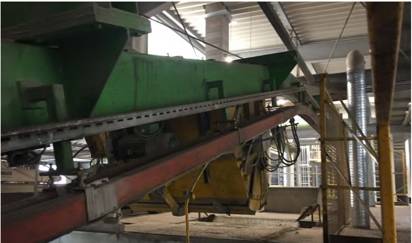
Abb. 102 Betontransport mit Kübelbahn
