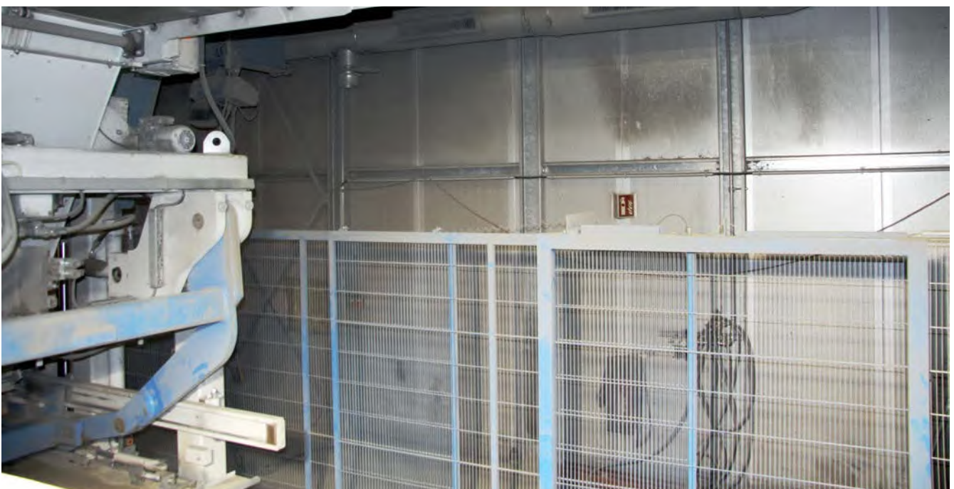
Abb. 60 Entstaubungstechnik im Bereich des Fertigers
