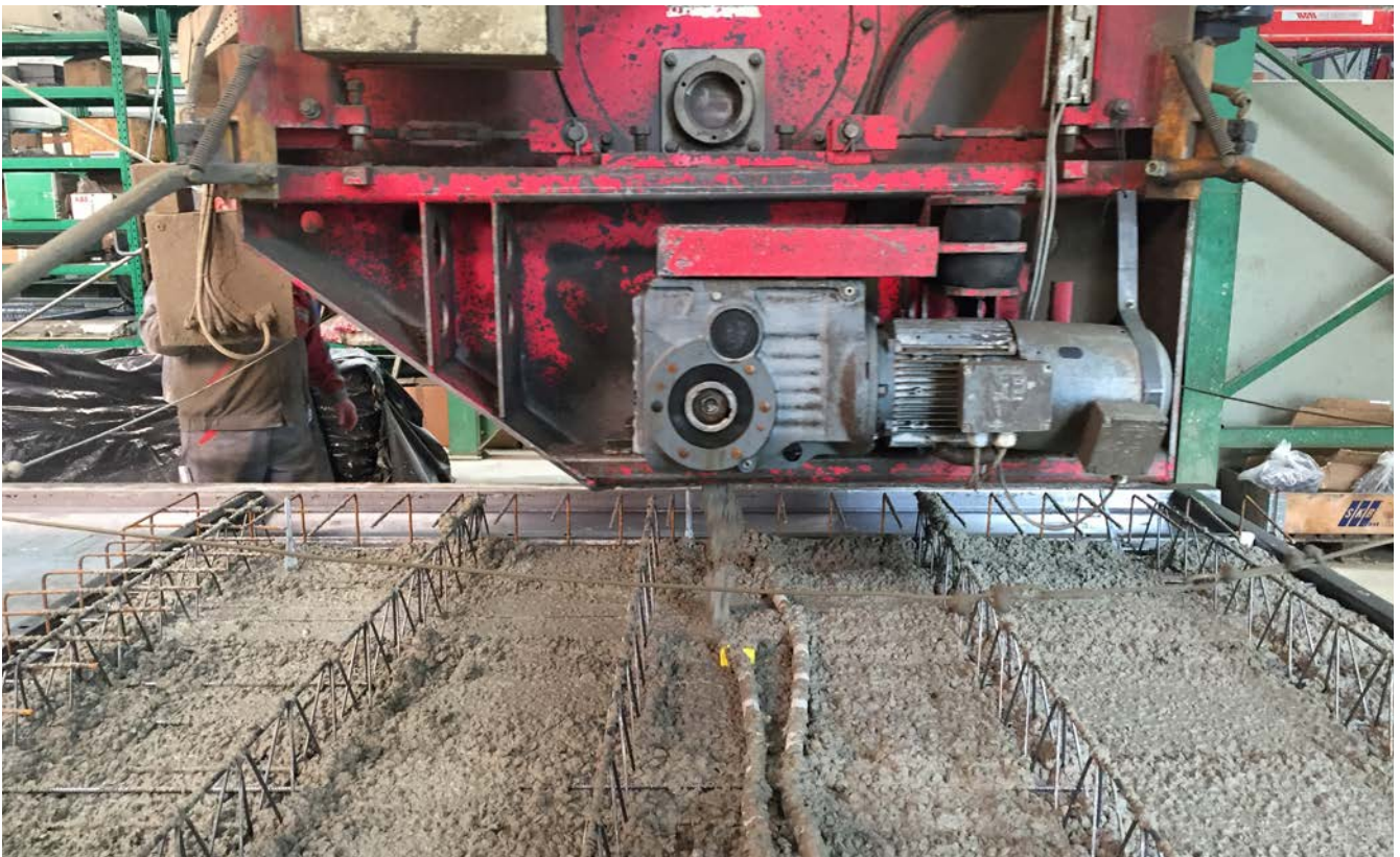
Abb. 9 Personengesteuerte Betonierarbeiten mit Betonverteiler
