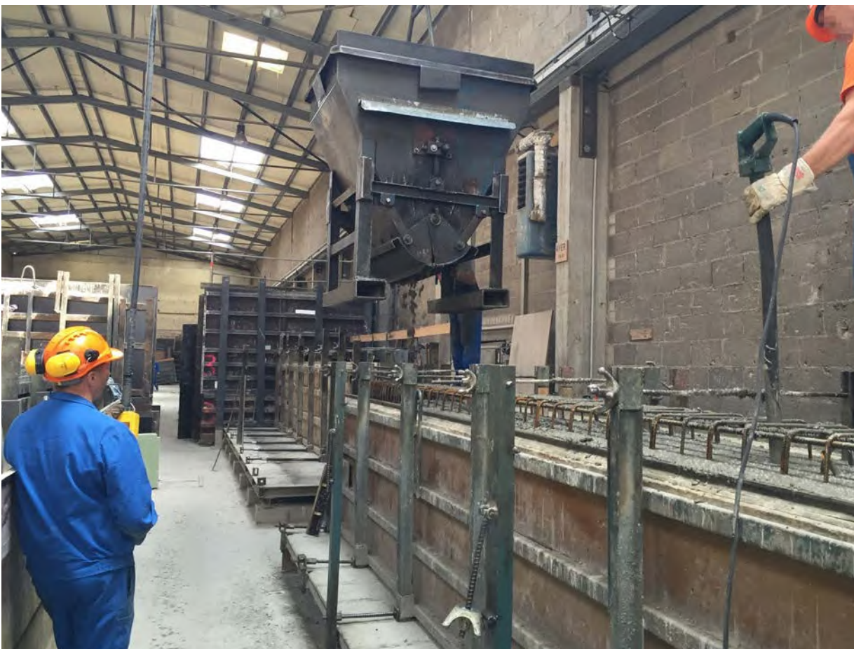
Abb. 104 Betonkübel am Kran
