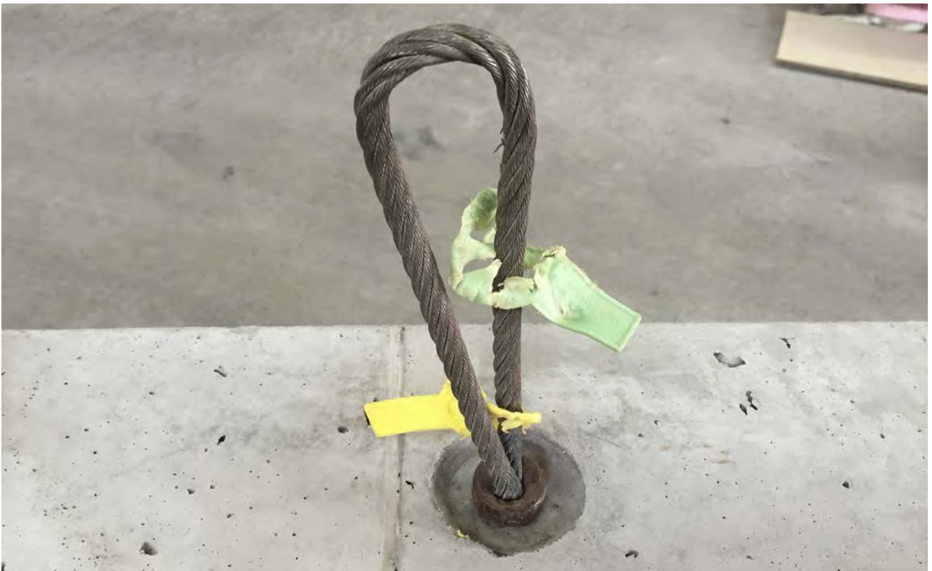
Abb. 33 Transportanker mit Lastaufnahmemittel
