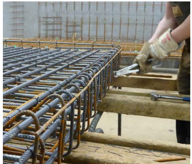
Abb. 25 ergonomisch günstige Arbeitshaltung bei Bewehrungsarbeiten
