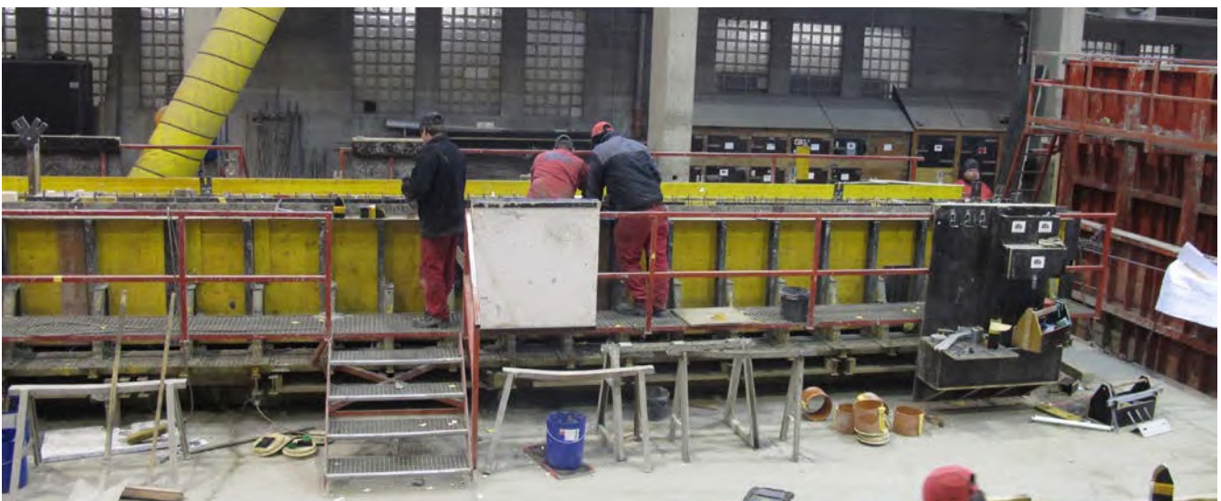
Abb. 32 Betonieren eines Betonfertigteilmehrschichtenbinders mit seitlichen Laufstegen
