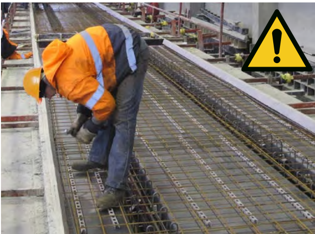
Abb. 80 NEGATIV ergonomisch ungünstige Haltung bei der Erstellung von Bewehrungen
