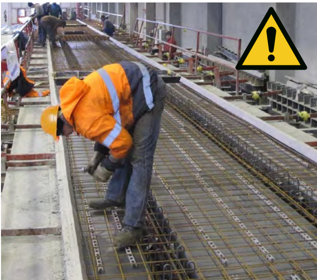
Abb. 24 Zwangshaltung bei Bewehrungsarbeiten (negativ!)
