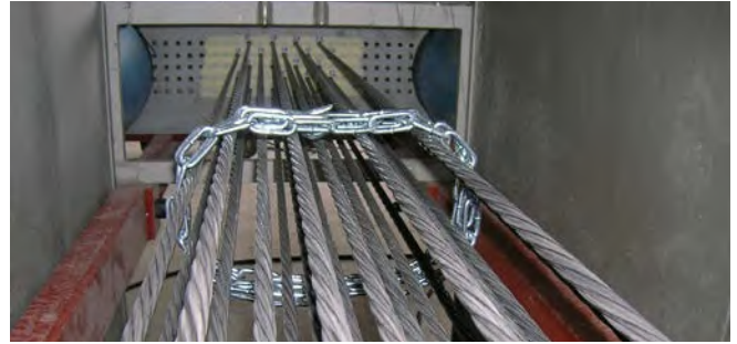
Abb. 30 Absicherung der Spanndrähte durch Ketten
