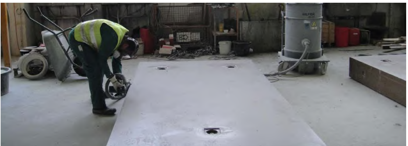
Abb. 90 Nutzung einer Absaugeinrichtung bei der Bearbeitung von Betonprodukten aus Polymerbeton
