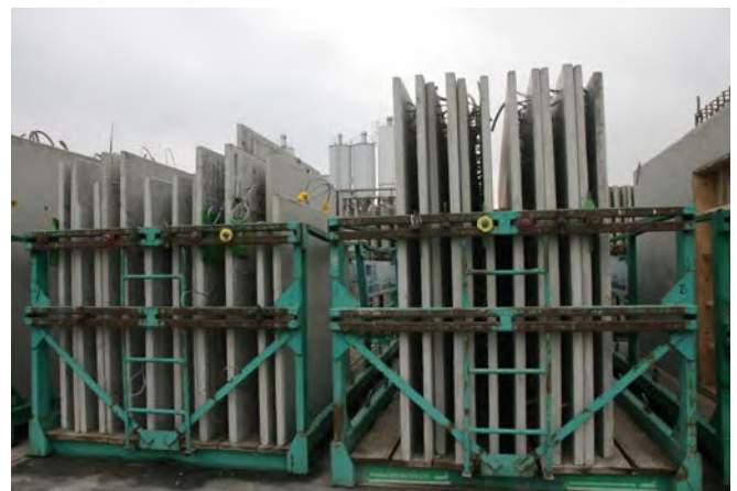
Abb. 5 Gabellagerung von Betonfertigteilen
