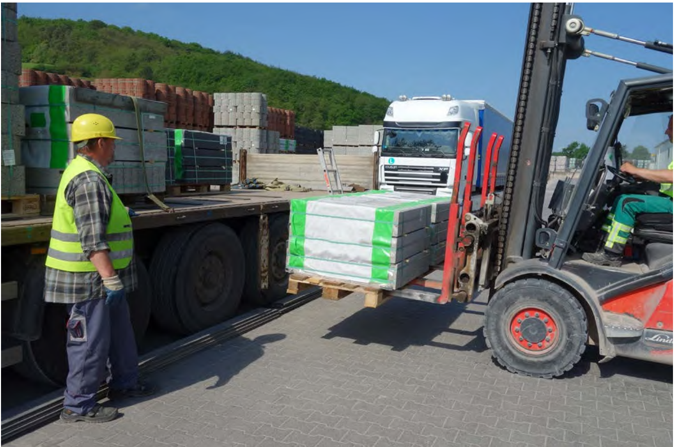
Abb. 65 Verladung Betonsteinpalette
