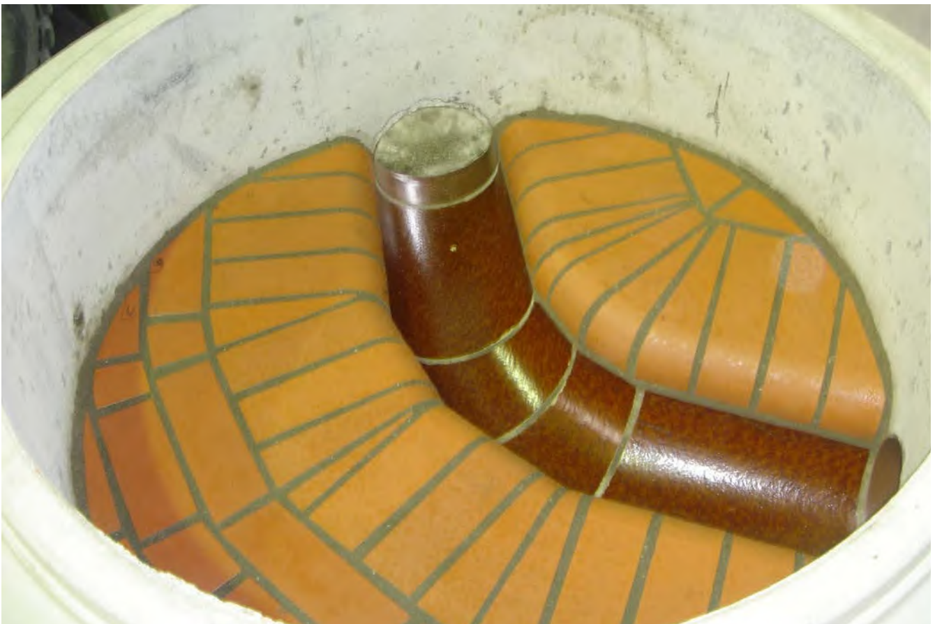
Abb. 52 Ausbau eines Schachtes mit gemauertem Gerinne vor der Verfügung
