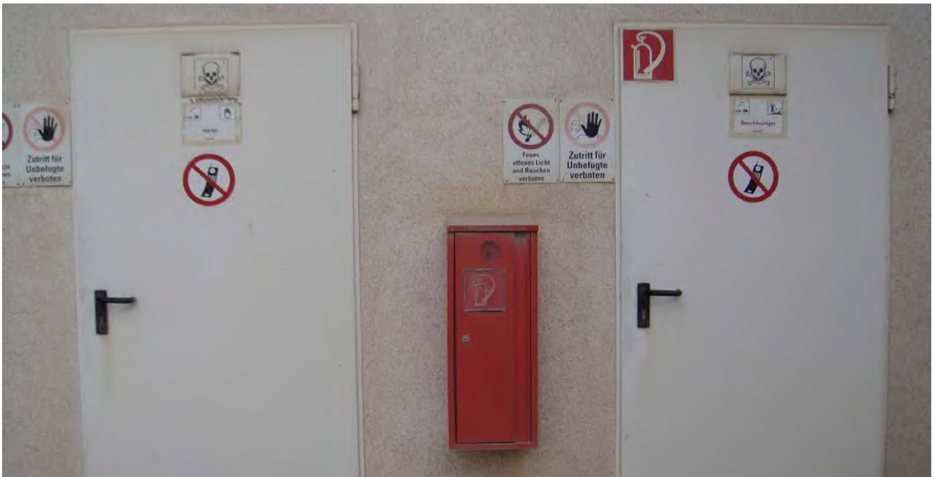
Abb. 88 getrennte Lagerung von Härter und Beschleuniger
