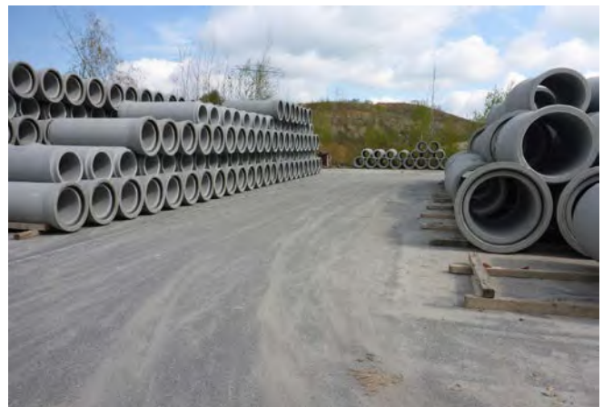
Abb. 108 Freilager-Wegrollsicherung durch Kanthölzer
