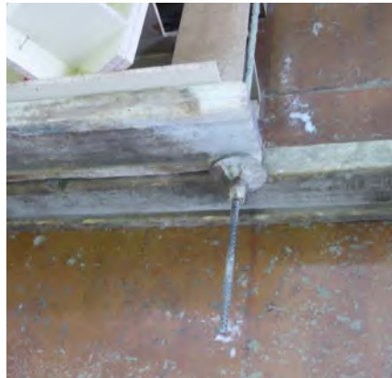
Abb. 22 Stolpergefahr durch überstehende Verbindungsmittel
