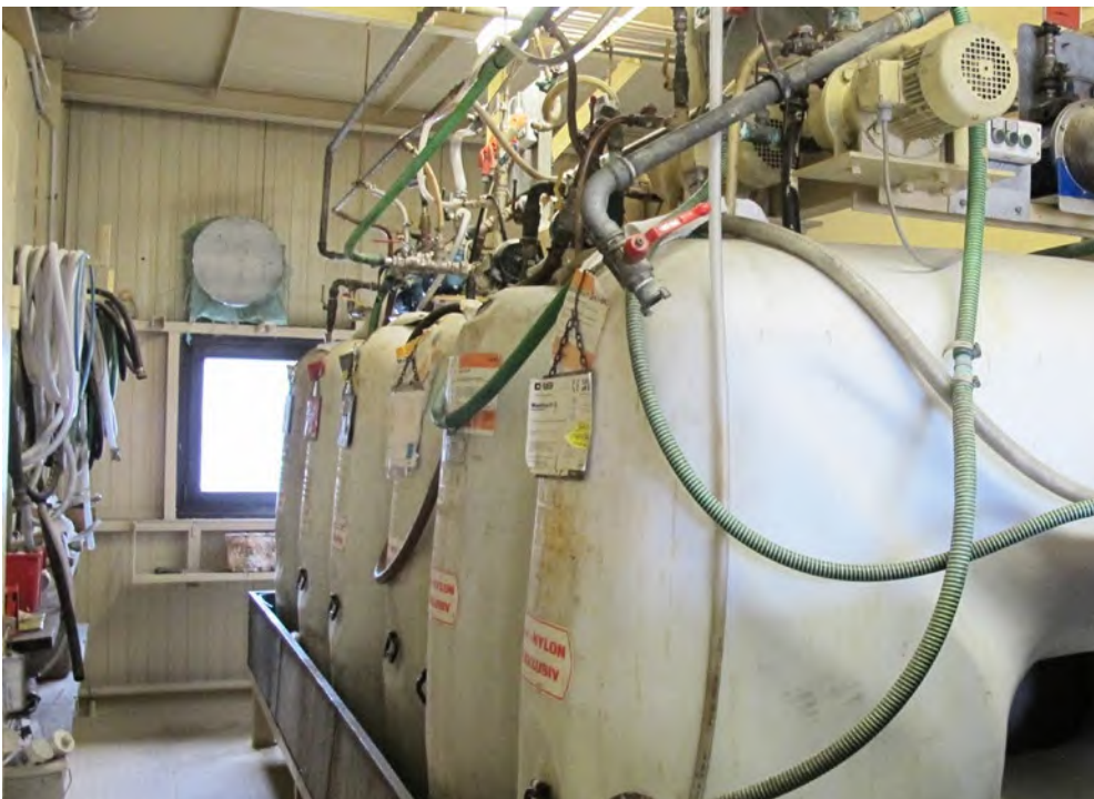
Abb. 11 Lagerung von Beton- zusatzmitteln
