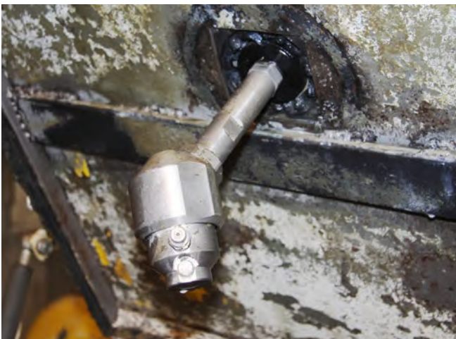
Abb. 24 Hochdruckreinigungsdüse in Betonmischer
