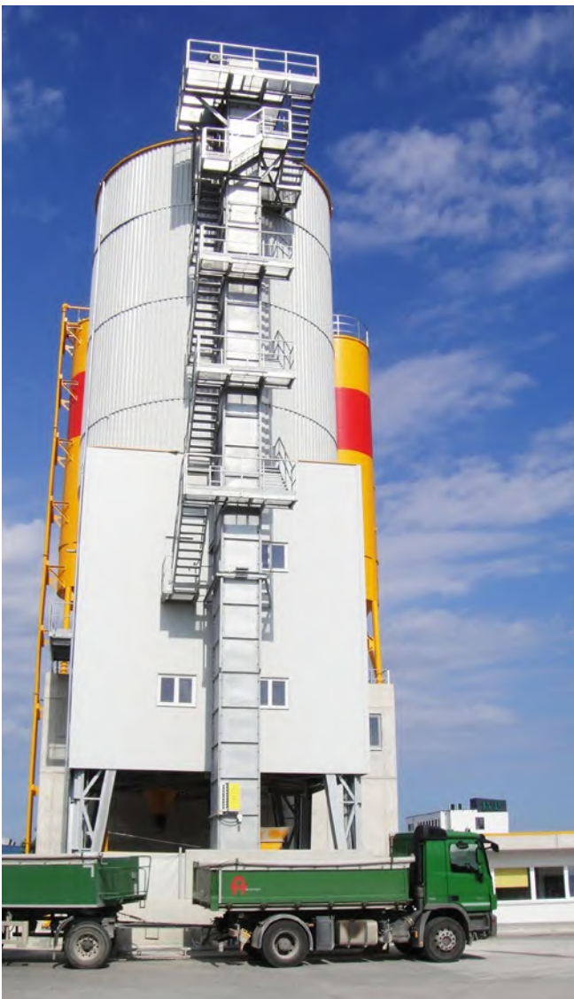
Abb. 19 Turmanlage mit Becherwerk
