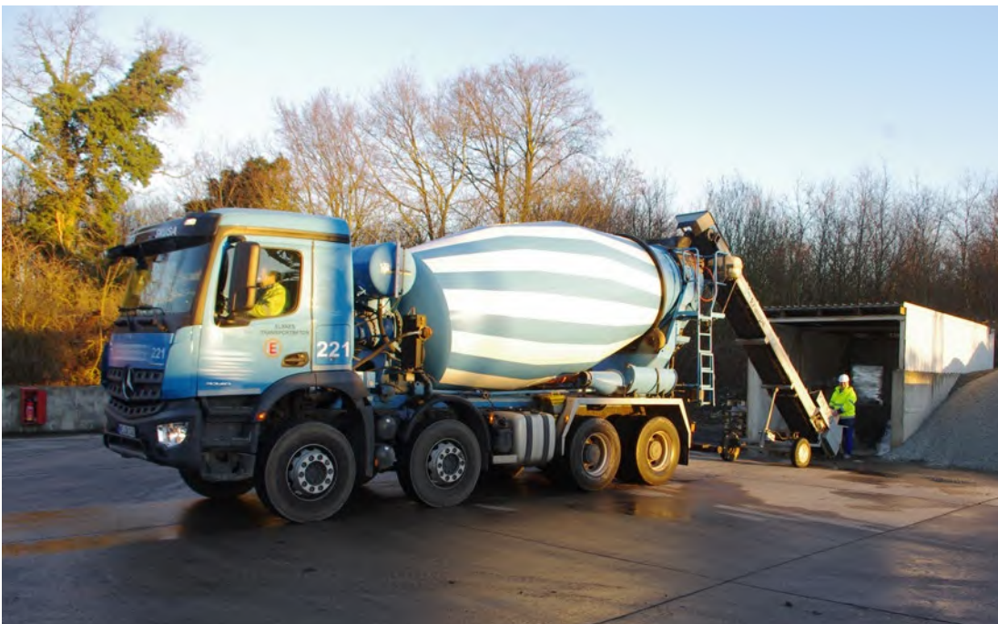
Abb. 8 Sicheres und ergonomisch günstiges Einbringen von Stahlfasern in den Fahrmischer
