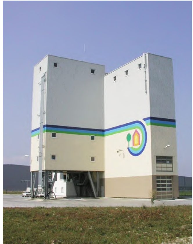
Abb. 2 Eingehauste Frischbetonanlage
