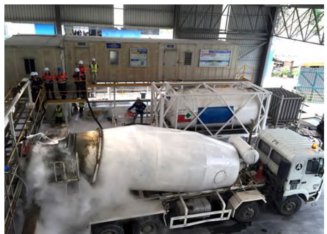
Abb. 14 Kühlung durch Lanzen mit flüssigen Stickstoff
