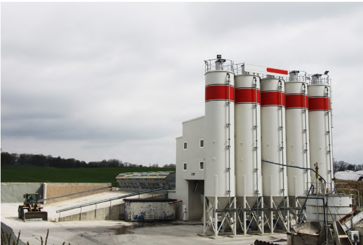
Abb. 39 Silos bei einer Frischbetonanlage
