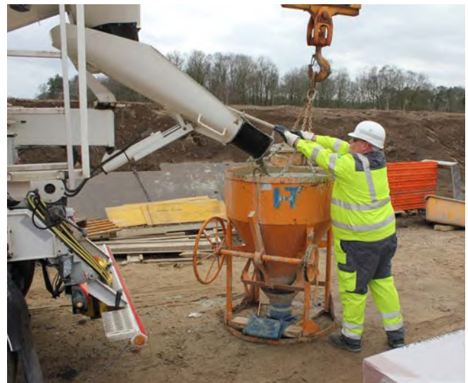
Abb. 19 Befüllung des Betonkübels
