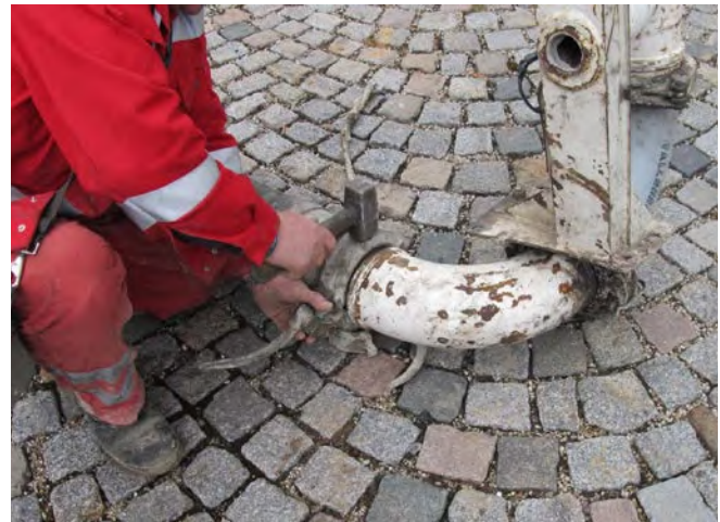
Abb. 33 Lärmeinwirkung beim Lösen einer Rohrkupplung mit Fäustel
