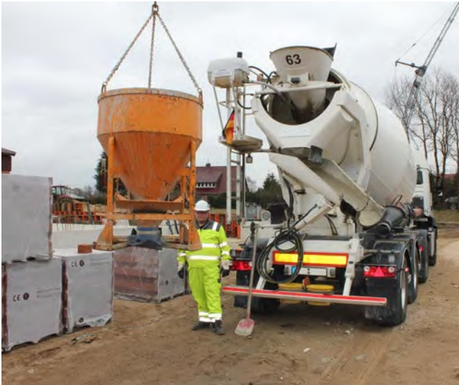
Abb. 18 Betonkübel am Baustellenkran
