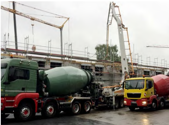
Abb. 20 Betonieren auf der Baustelle mit verschiedenen Arbeitsmitteln
