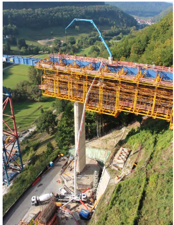
Abb. 1 Brückenbaustelle mit Betonpumpeneinsatz und Frischbetonversorgung durch Fahrmischer
