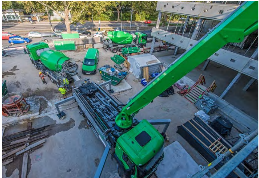
Abb. 3 Gute Organisation des Einsatzes von Betonpumpe und Fahrmischer auf der Baustelle
