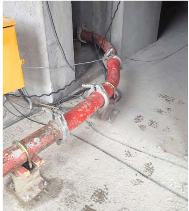
Abb. 35 Rohrbefestigung für den Betoniervorgang
