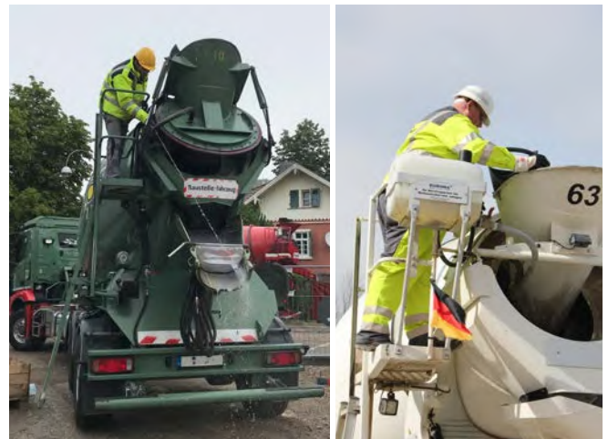
Abb. 21 Reinigen des Einlauftrichters und der Auslaufschurre
