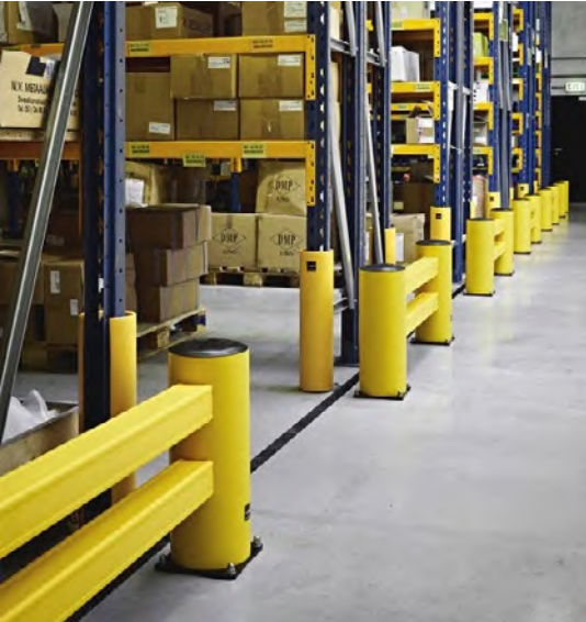
Abb. 44 Positivbeispiel eines Regals mit Anfahrtschutz
