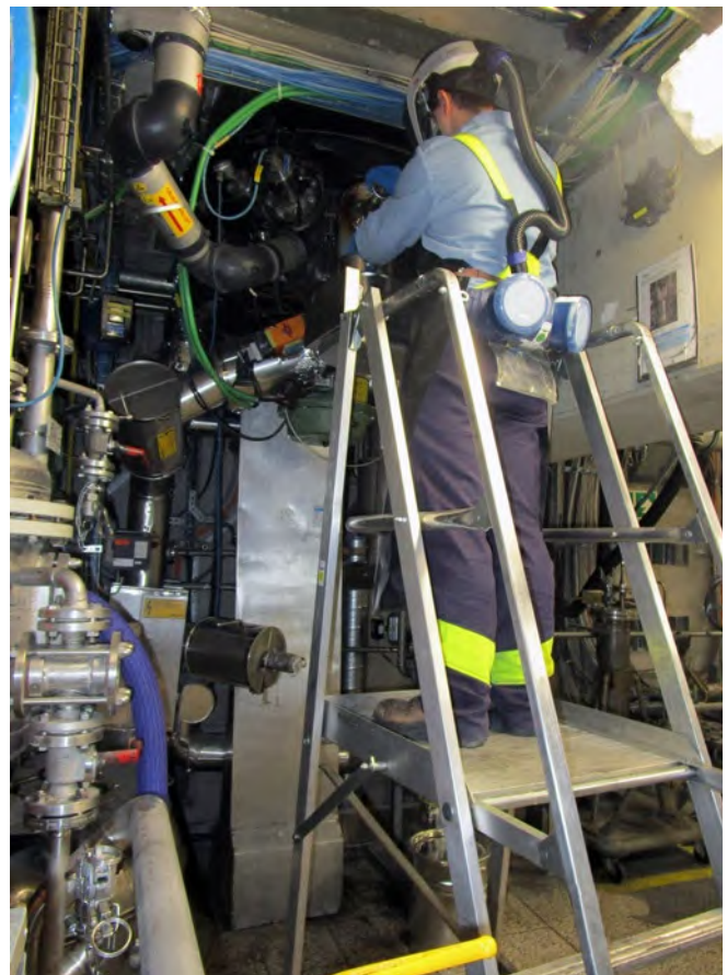
Abb. 24 Aufstiegshilfe zur Probenahmestelle
