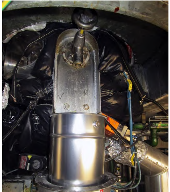
Abb. 26 Probenahmehahn
