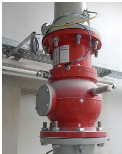
Abb. 59 Explosionssicherungsventil an druckstoßfest ausgelegter Mühle
