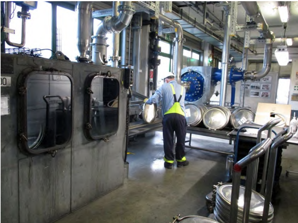
Abb. 51 Deckelreinigungsanlage mit nach unten abgesaugtem Abtropftisch
