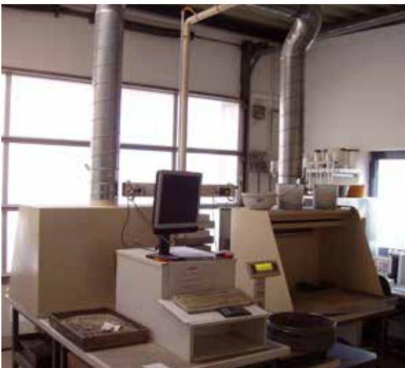
Abb. 82 Stauberfassung im Labor
