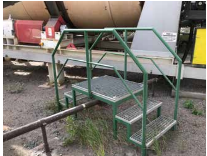
Abb. 38 Sichere Verkehrswege über Rohrleitungen
