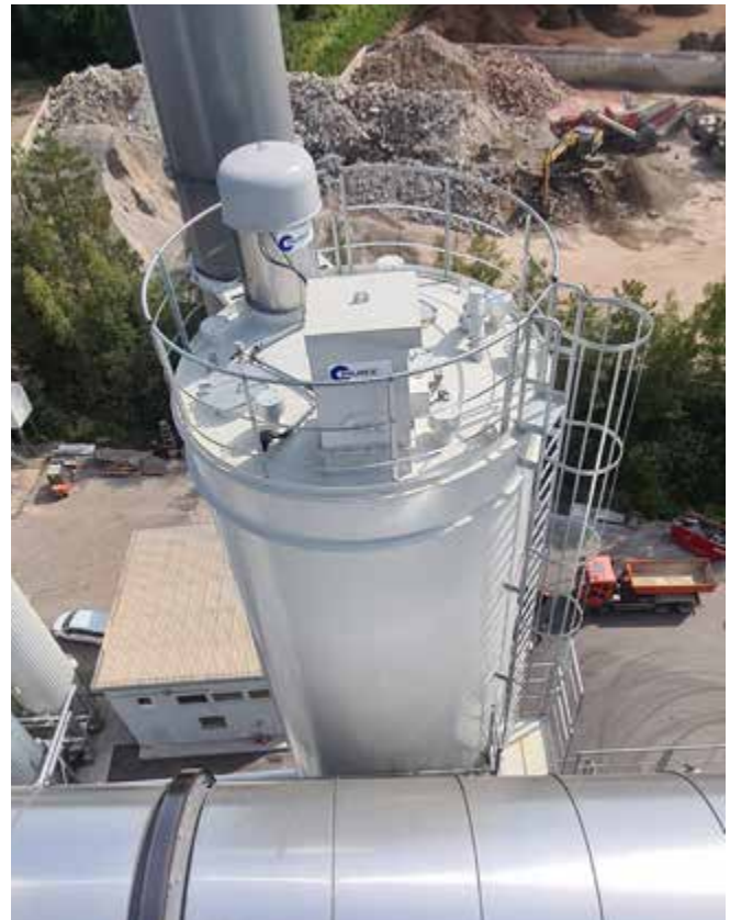
Abb. 72 Silodach mit umlaufendem Geländer
