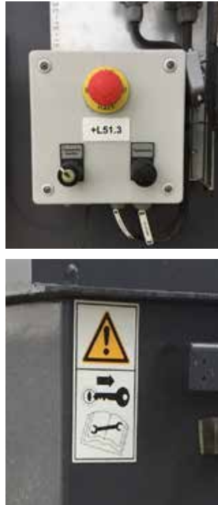
Abb. 33: Becherwerk-Klappe mit Schlüssel-Transfer-System und Vor-Ort-Schaltung
