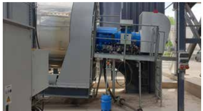
Abb. 36 Sicherer Arbeitsstand am Brenner
