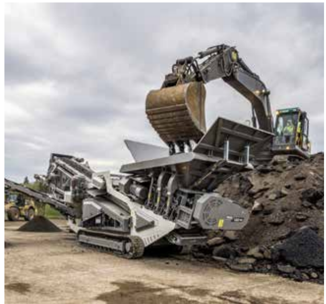
Abb. 55 Materialaufgabe mit Bagger von sicherer Standfläche
