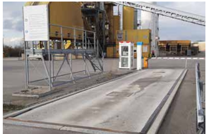
Abb. 4 Zufahrtsbeschränkung mit Terminal zur Kommunikation
