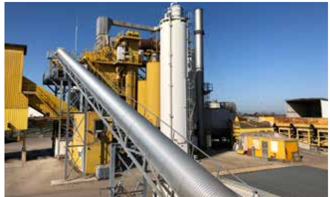
Abb. 61 Abgedecktes Förderband für die Zugabe von Asphaltgranulat in den Mischer über Kaltzugabe
