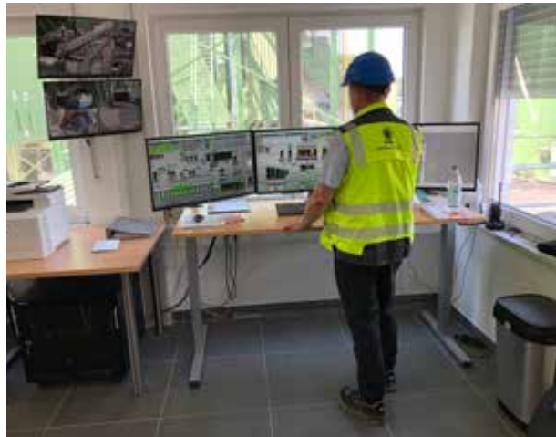
Abb. 63 und 63a Moderner Steuerstand im Asphaltmischwerk mit höhenverstellbarem Tisch
