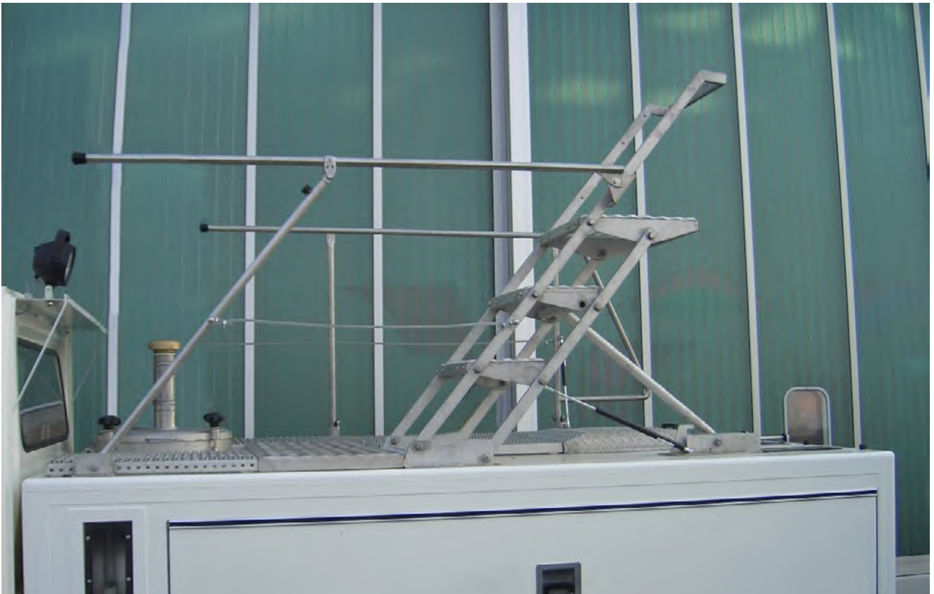
Abb. 79 Absturzsicherung auf einem Servicefahrzeug
