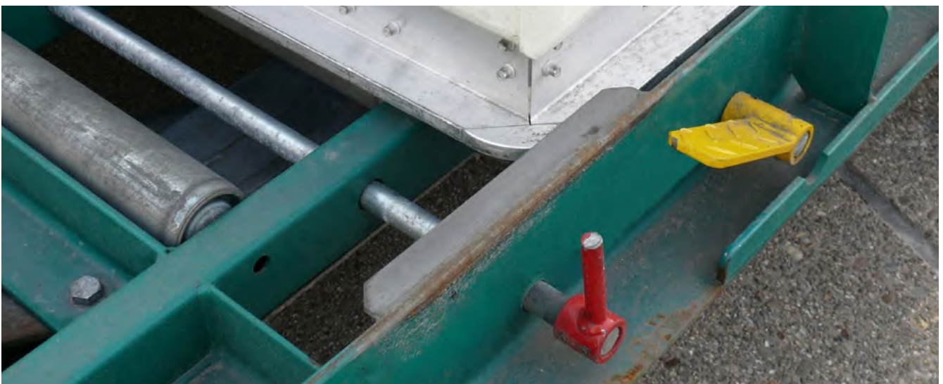
Abb. 62 Dolly mit zusätzlichem Sicherungsblech
