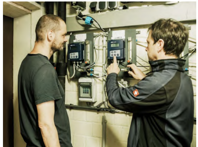
Abb. 41 Tätigkeitsspezifische Unterweisung in einem Aquarium
