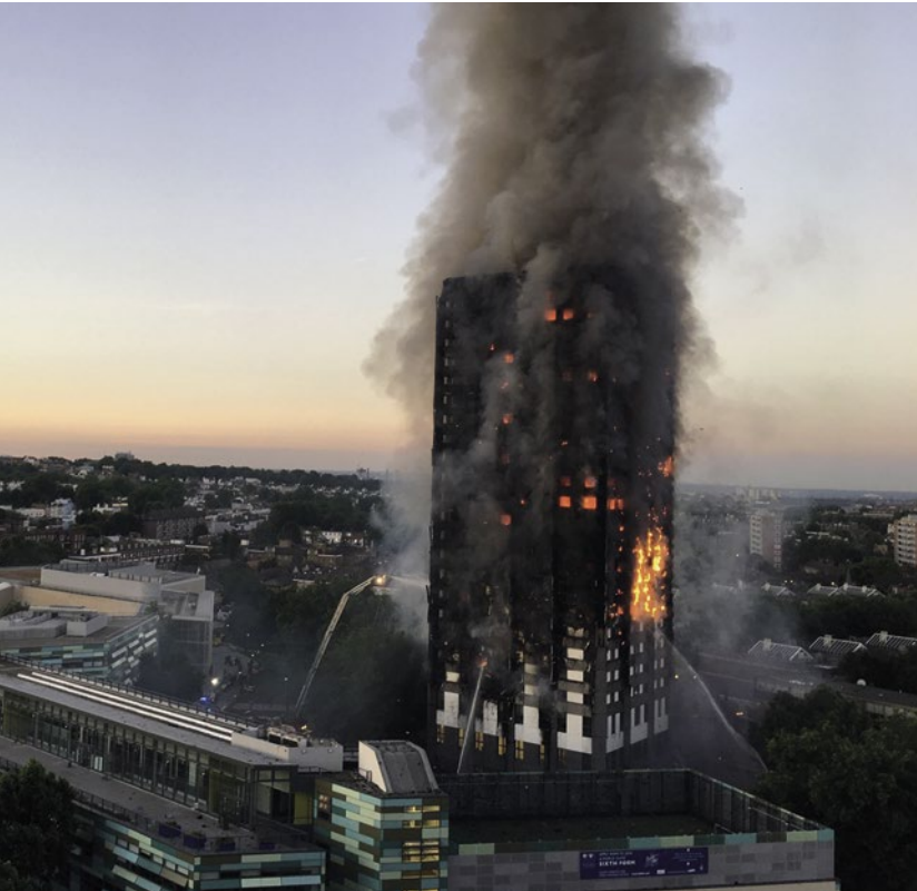
Bild 4: Fassadenbrand Grenfell Tower
