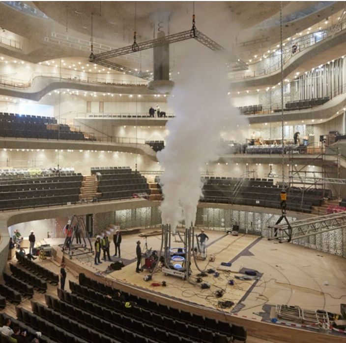
Bild 10: Rauchversuche im großen Saal der Elbphilharmonie
