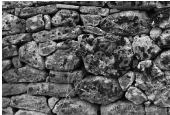
Bild NA.L.13 — Beispiel für Findlingsmauerwerk
