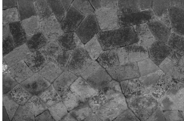
Bild NA.L.15 — Beispiel für Zyklopenmauerwerk
