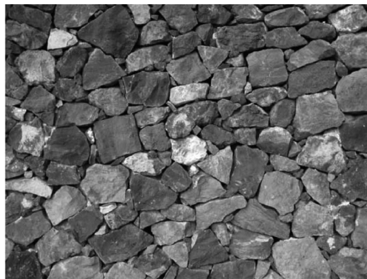
Bild NA.L.14 — Beispiel für Bruchstein-Zyklopenmauerwerk
