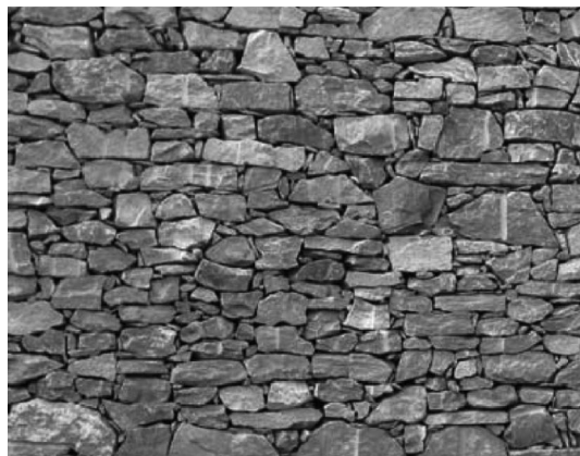
Bild NA.L.16 — Beispiel für Bruchstein-Schichtenmauerwerk
