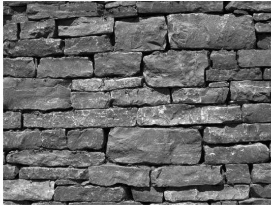
Bild NA.L.17 — Beispiel für Schichtenmauerwerk Güteklasse N2
