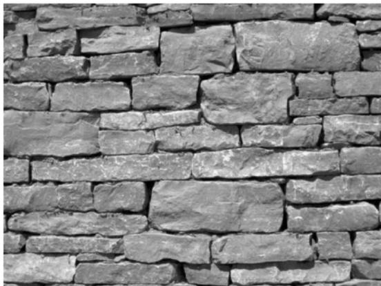
**Bild NA.L.5 — Beispiel für Schichtenmauerwerk Güteklasse N2**
