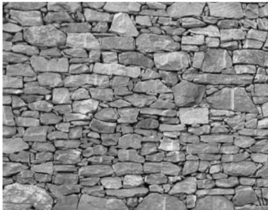
**Bild NA.L.4 — Beispiel für Bruchstein-Schichtenmauerwerk**
