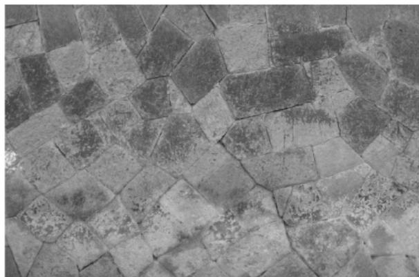
**Bild NA.L.3 — Beispiel für Zyklopenmauerwerk**
