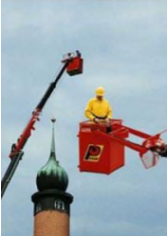
Arbeitsplattformen, die mit Ladekränen zusammengebaut sind
