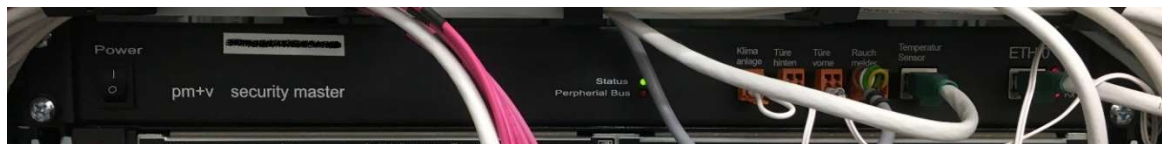
Abbildung 23: Schranküberwachungseinheit
