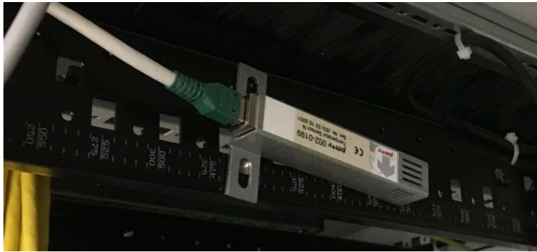
Abbildung 24: Temperaturüberwachung
