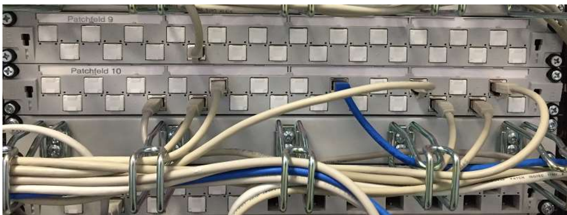
Abbildung 28: Patchfeld für Module RJ-45 Buchsen
