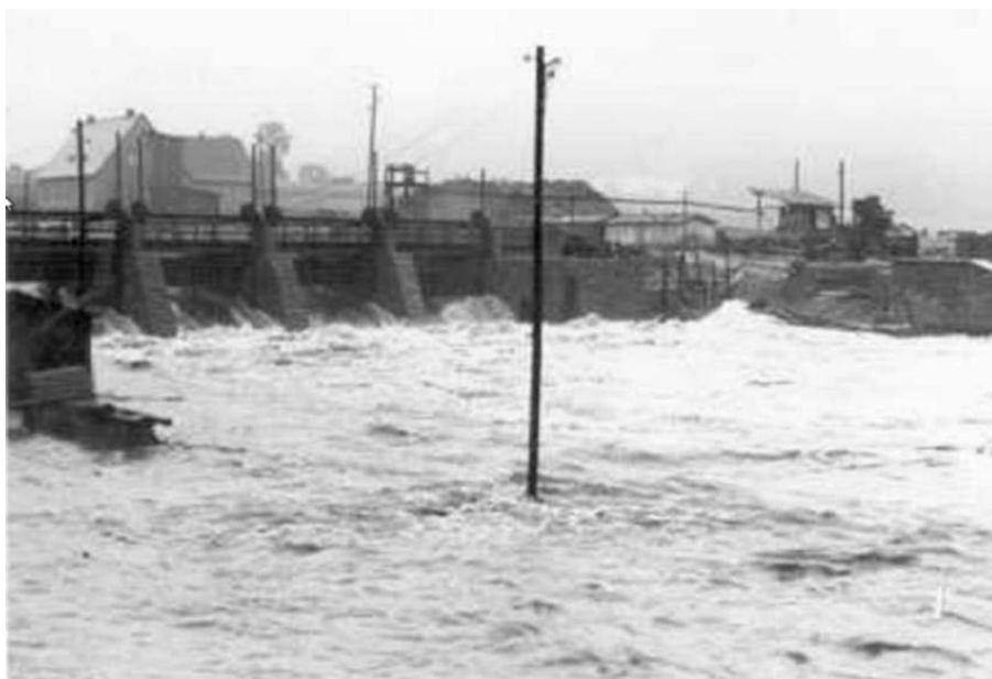
Anhang 6, Abb. 10: Blick auf das Wehr während des Hochwassers von 1954
