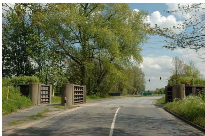
Anhang 4 Abb. 5: Hochwasserschutztor eines Betriebsbereichs
