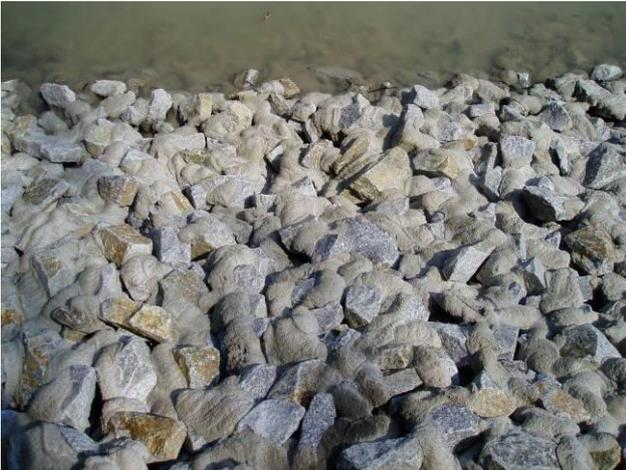
Bild A4-1: *Sachgerecht hergestelltes teilvergossenes Deckwerk (30 l/m<sup>2</sup>, CP<sub>90/250</sub>, Einbau von Hand)*
