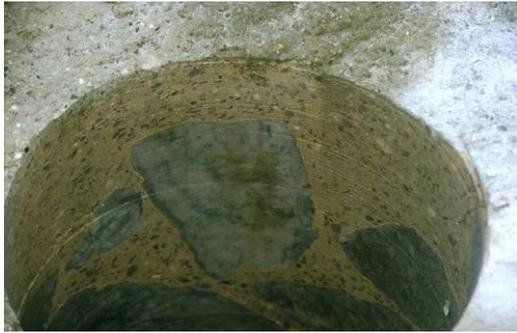
*Bild A4-4: Blick in eine Großbohrung in ein vollvergossenes Deckwerk*
