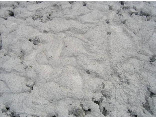
Bild A4-2: ***Nicht** sachgerecht hergestelltes teilvergossenes Deckwerk mit zu steifem Vergussstoff (70 l/m<sup>2</sup>, CP<sub>90/250</sub>, Einbau von Hand)*
